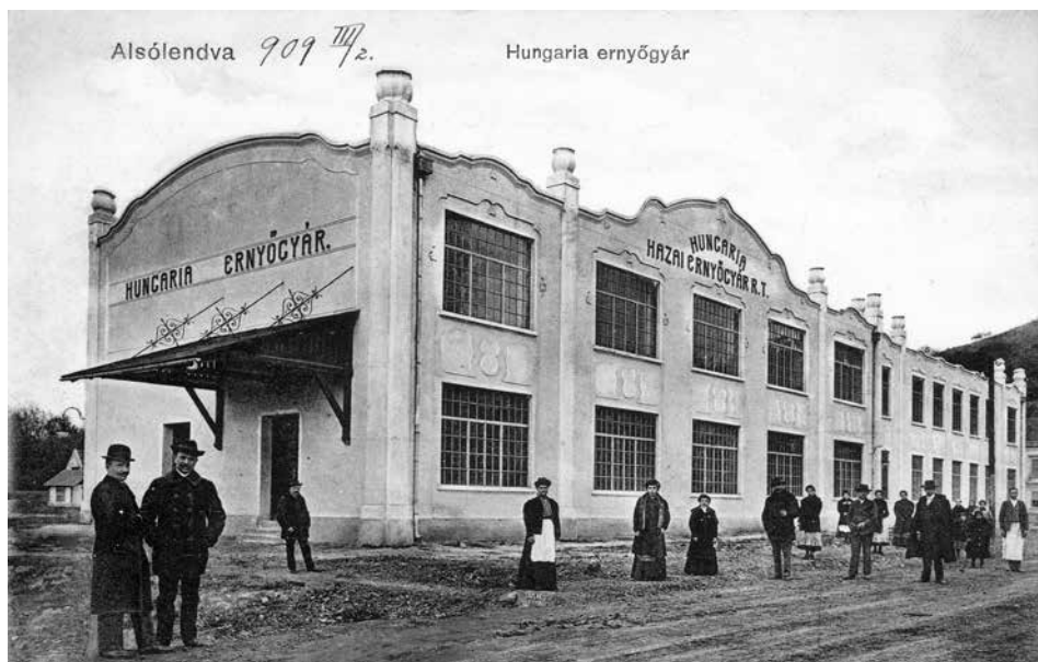
Slika 3: Stavba tovarne dežnikov v Dolnji Lendavi, 1909 (vir: razglednica, Štefan Vida).
